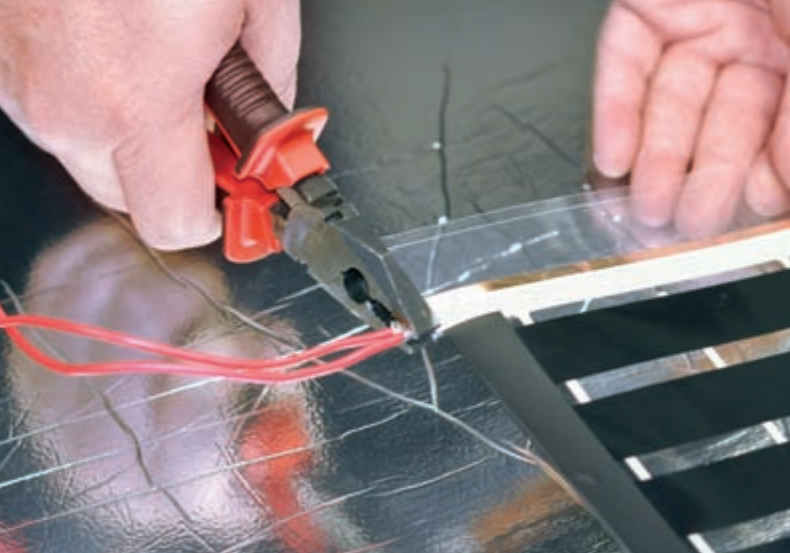
Рис. 16. Надежно зажмите провода в контактном зажиме
