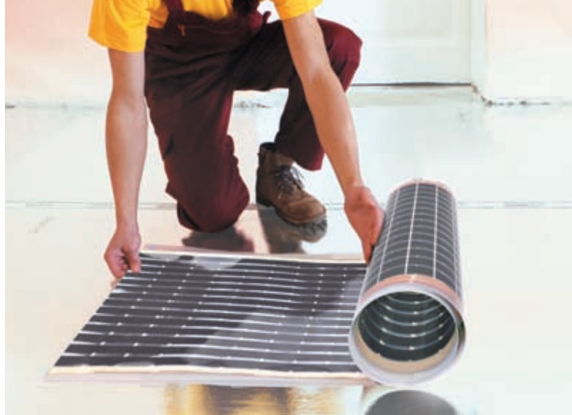
Рис. 5. Раскатывание рулона теплого пола CALEO PLATINUM на теплоотражающем материале
