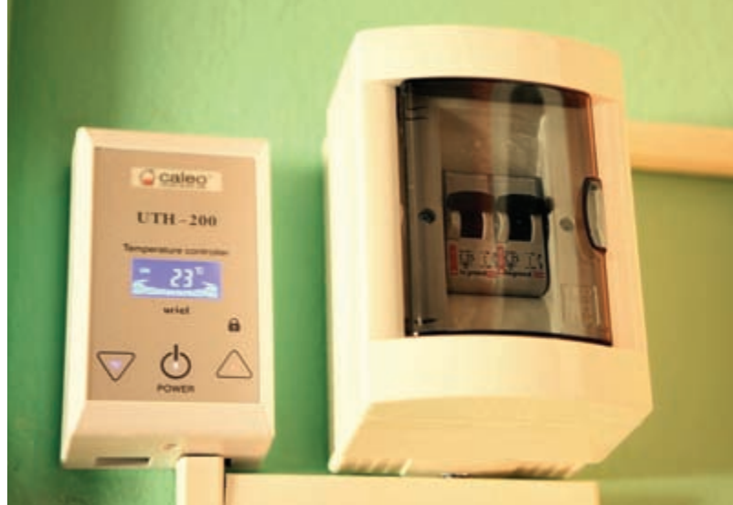
Рис. 27. Терморегулятор, подключенный к сети через отдельный автомат
