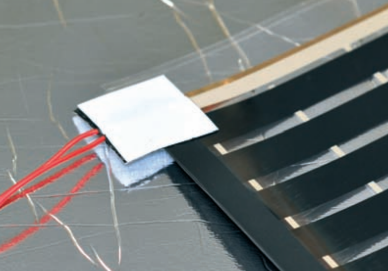
Рис. 20. Вид заизолированного контактного зажима с подключенными проводами
