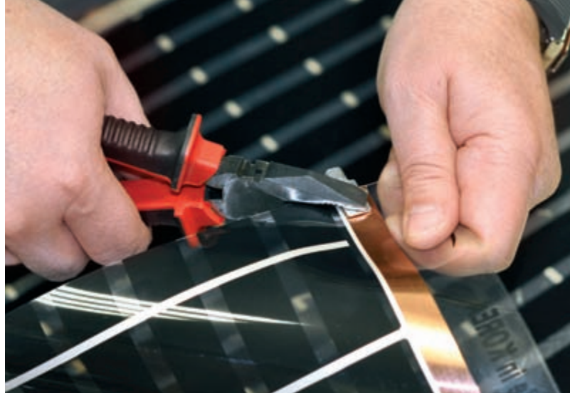
Рис. 10. Крепление контактного зажима к термопленке (обжатие плоскогубцами)
